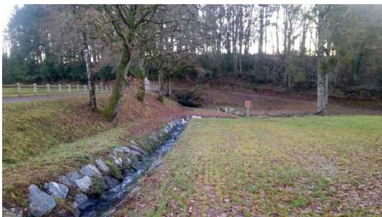
Illustration 38: Exemple d'une dérivation à ciel ouvert en pied de digue, avec enrochement de stabilisation (source : géonat)
