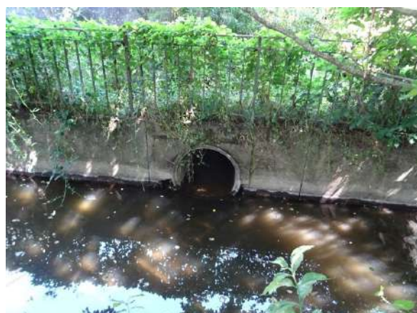
Illustration 21: Rejet pluvial en bordure de route D927 (Gourdon, GOU301)
